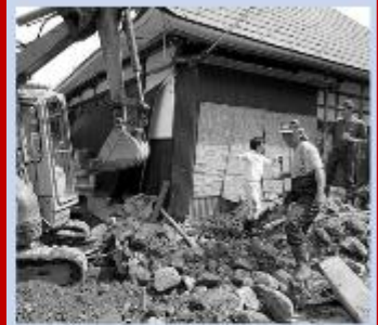
土砂の撤去作業
