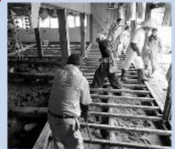
家屋床下に残る泥出し作業
